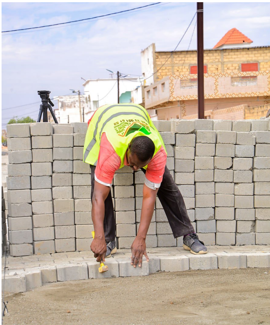
Construction de routes en pavés à Touba Nda- matou sur 1km 200 avec drainage des eaux pluviales et aménage- ment de trot- toirs
