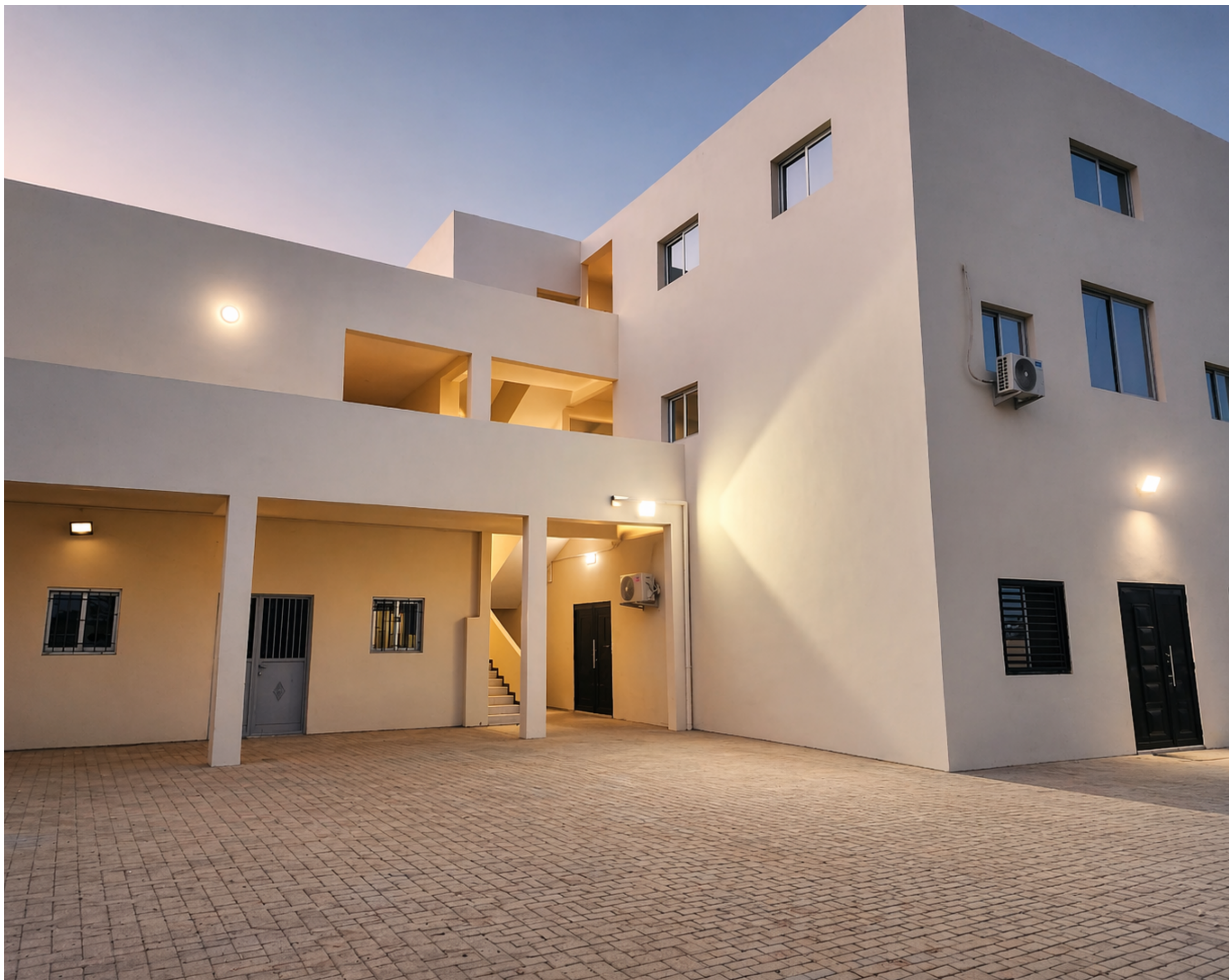
Construction bâtiment an- nexé de la Mairie Thiès Nord en R+2 et pavage
